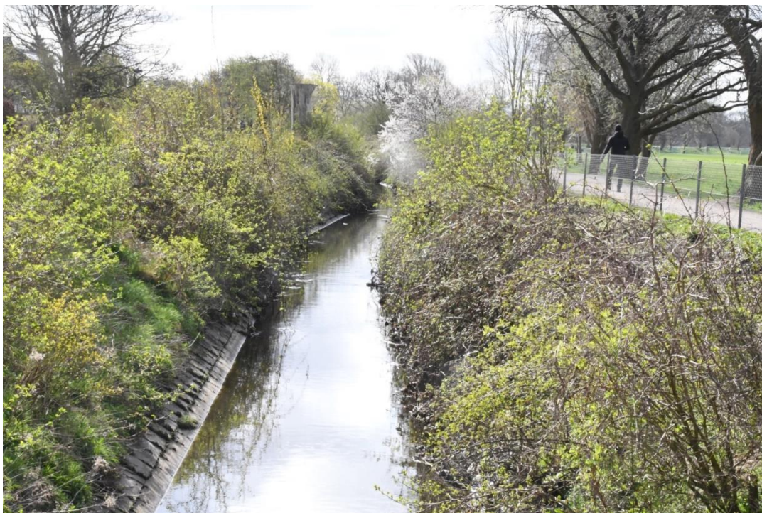
Figur 26. Vandløbet langs engen er stensat og heget ind.
