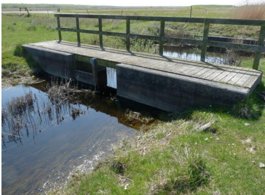
Figur 91. Samme opstemning som ovenfor. Vandstanden kan hæves mindst 30 cm.
