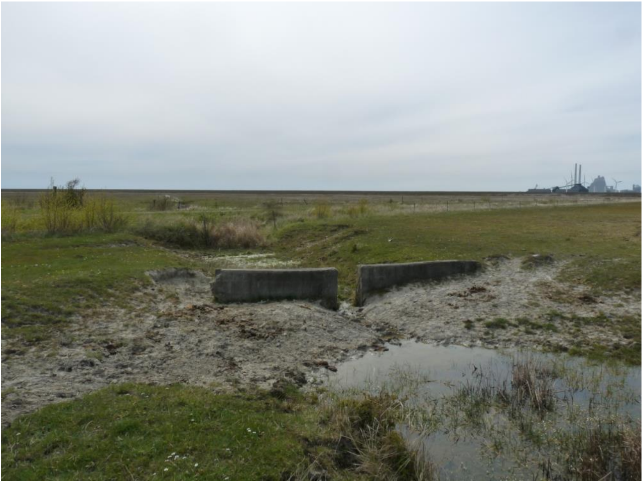
Figur 70. Dette stigbord i omr. 4b fungerer ikke. Omgivelserne er helt nedslidt af kreaturer. Cementstigbordet er intakt. Der skal blot et bræt i, og så skal der fyldes materiale på omkring stigbordet, så vandet løber over brættet og ikke ved siden af. Det vil være vigtigt at sikre, at kreaturerne kan passere grøfterne på steder, hvor der ikke sker et uheldsmæssigt slid på opstemningerne. Evt. skal selv et stigbord sikres med hegn.
