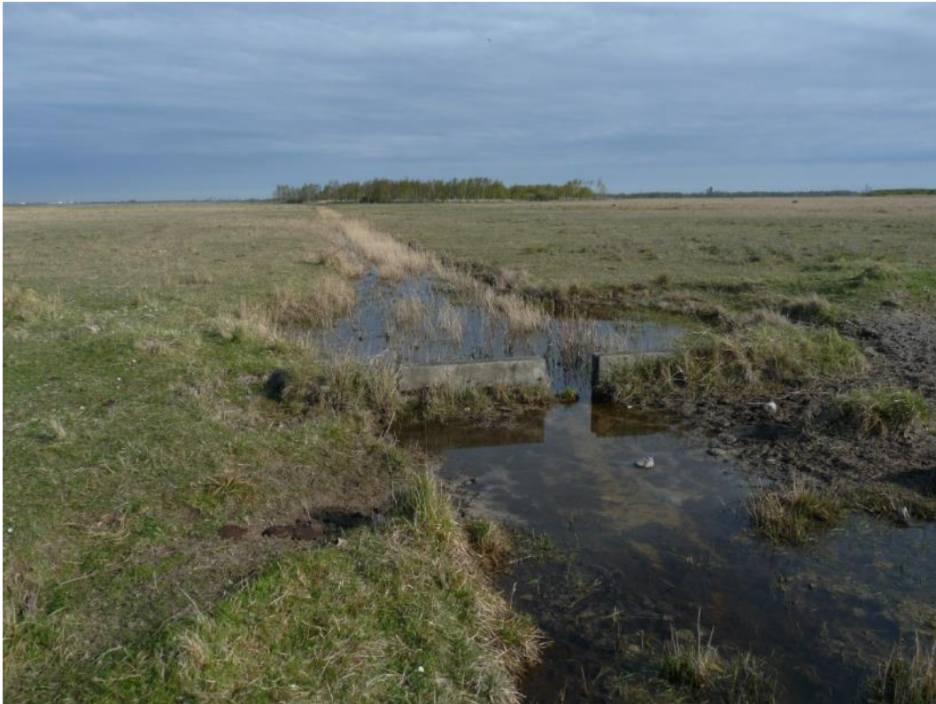
Figur 82. Et stigbord i 5b, som ikke fungerer.
