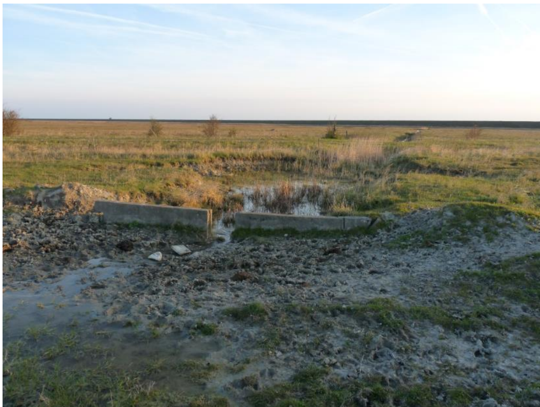
Figur 81. Defekt og ikke-fungerende stigbord i omr. 3c.
